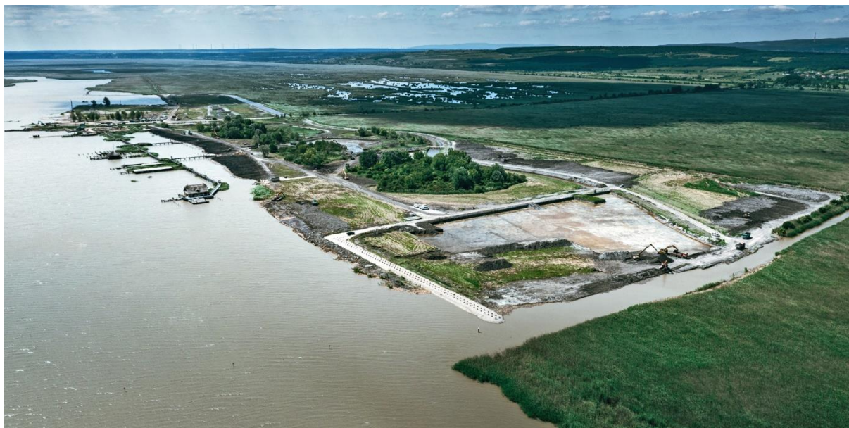
Abbildung 3: Luftansicht der Baufäche und der angrenzenden intakten Feuchtgebiete im Juni 2021 (Ausschnitt einer Drohnenaufnahme, Blickrichtung etwa nach Südwesten). © Greenpeace, Mitja Kobal.
